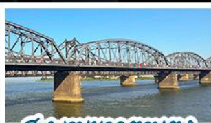
สะพานขาดตานตง
